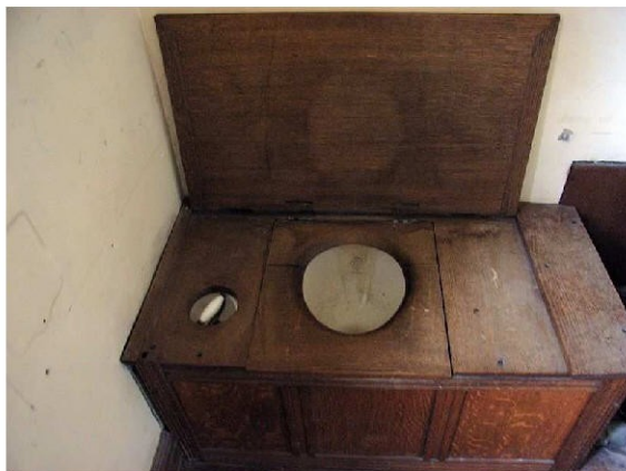
Der Vorläufer der modernen Wasserklosetts, gespült wurde mit der Handpumpe links.
